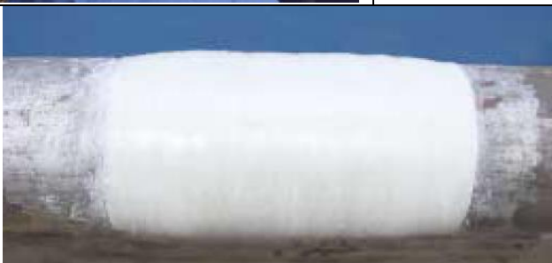
CONDOTTA RISANATA CON IL KIT DI RIPARAZIONE SG-NP
