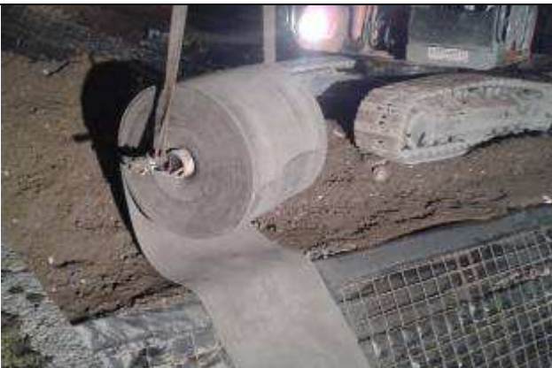
particolare movimentazione con escavatore
