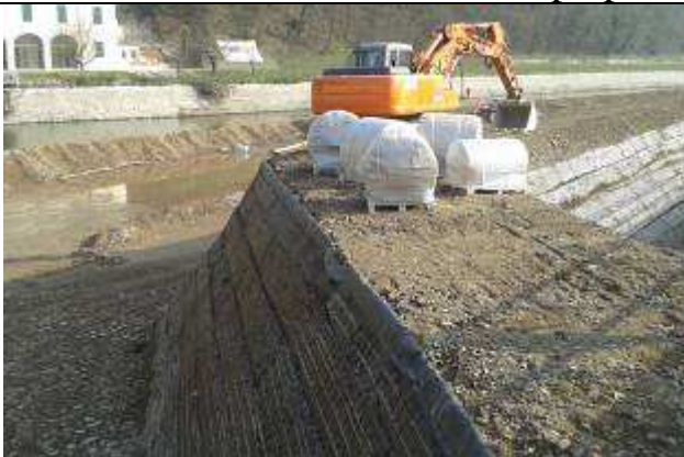
arrivo CC8 in cantiere
