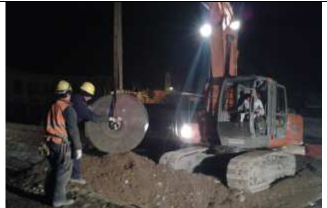
movimentazione della bobina di CC8
