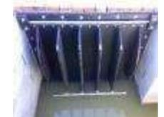
**MONTAGGIO** : Le valvole a clapet della serie PE presentano l'estremità predisposta per fissaggio su flangia o a muro; verificare la verticalità della flangia, forare la cornice della valvola ove necessario, interporre guarnizione o silicone e ancorare con bulloni e dadi.
