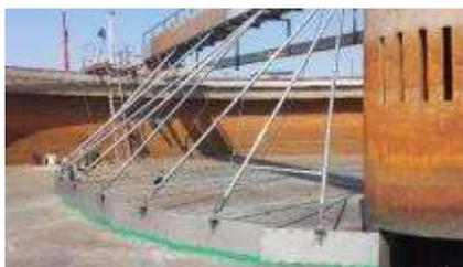
Voce di capitolato tipica – ponte raschiafango in acciaio al carbonio zincato a caldo per le parti emerse e in esecuzione acciaio inox AISI 304 per le parti immerse e composto da :
