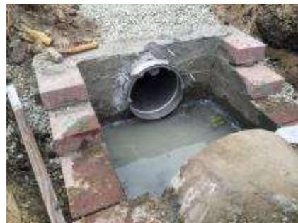
**VOCE DI CAPITOLATO :** Fornitura di valvola antiriflusso WS in gomma del tipo azionato dal fluido da applicare in linea su condotta De ..... mm ; corpo flessibile deve essere costruito in un unico pezzo di gomma contenuto all'interno di un guscio in ..... (acciaio inox - PVC - PEAD). Tenuta idraulica 5m H2O
