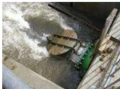
VOCE DI CAPITOLATO : fornitura di valvola a clapet in acciaio ..... ( zincato - inox AISI 304 - inox AISI 316 ) a sezione circolare in esecuzione compatta con tenuta su tutta la circonferenza; tenute in EPDM, carico idraulico 3 m H2O; telaio con struttura autoportante per fissaggio ..... ( ad innesto maschio su tubo avente diametro interno Di.....mm – a muro – su flangia con foratura PN 10 o con flangia a richiesta)
